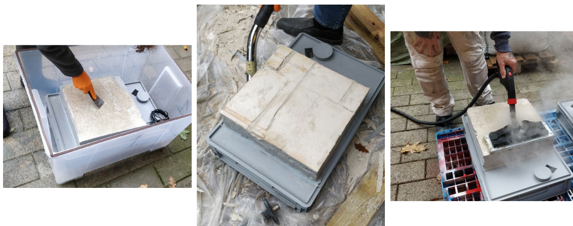
Figur 5. Afrensning ved håndkraft og spatel, mekanisk afbankning af pudslag og dampafrensning.
